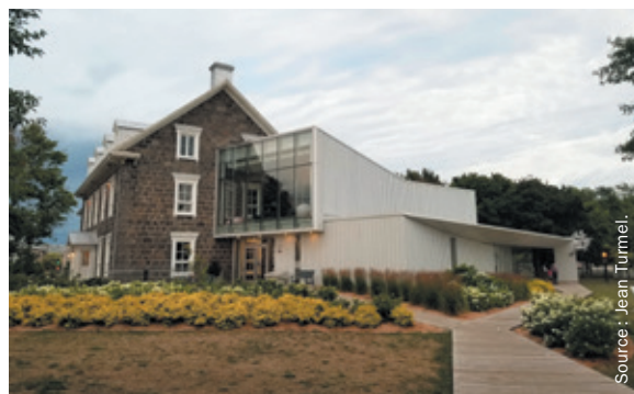
Figure 3.5.b LA BIBLIOTHÈQUE DE MONTMAGNY
