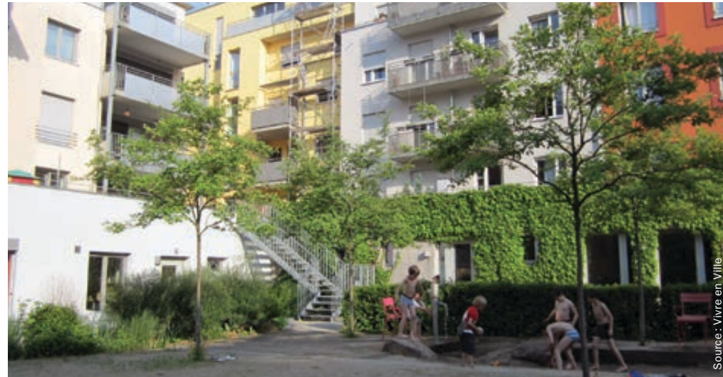
Figures 2.6.f-g DE VASTES COURS INTÉRIEURES AMÉNAGÉES
