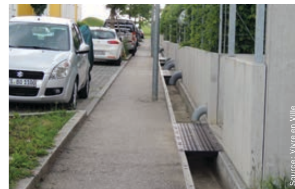
Figures 2.2.dd-ii L'EAU DE PLUIE GÉRÉE EN SURFACE SUR LE SITE, PLUTÔT QUE PAR DES ÉGOUTS PLUVIAUX
