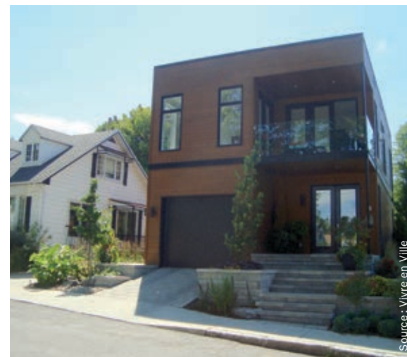
Figure 3.3.i RÉSIDENCE DE LA RUE GÉNÉRAL-VANIER
