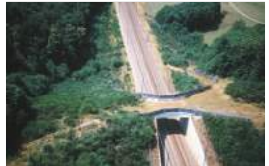
Figure 54 : Passage au-dessus d'une ligne de TGV.
