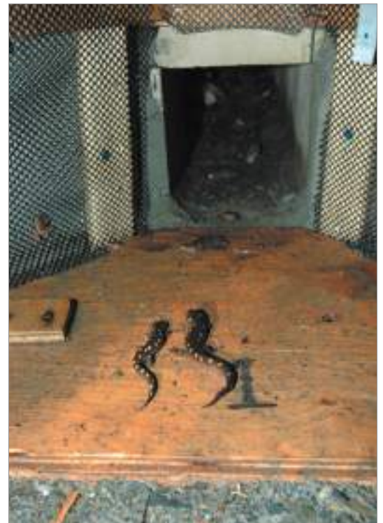
Figure 57 : Entrée du passage pour amphibiens.
