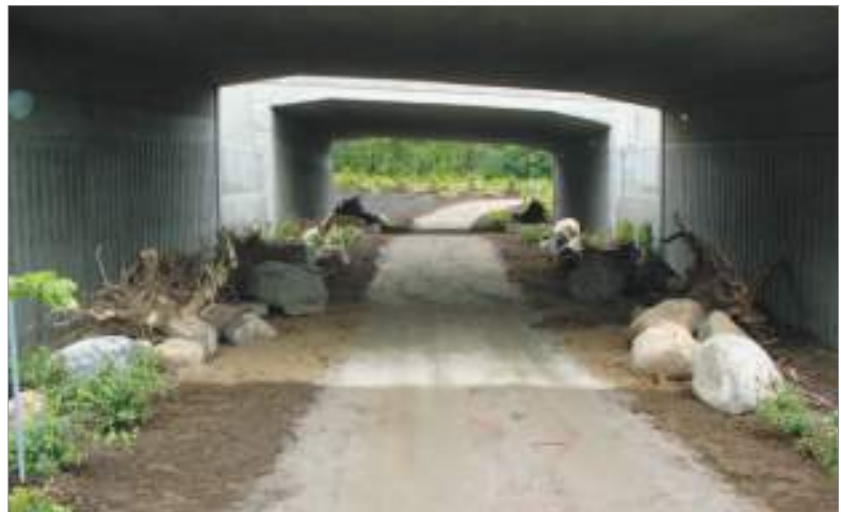
Figure 6-C : Passage inférieur mixte.
