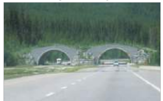
Figure 55 : Passage aérien, Alberta.
