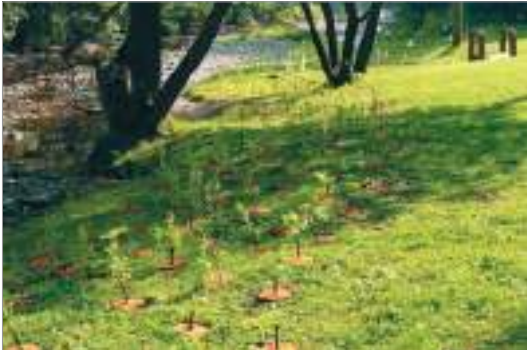
Figure 106 : Plantation sur les berges du ruisseau d'Ardoise.
