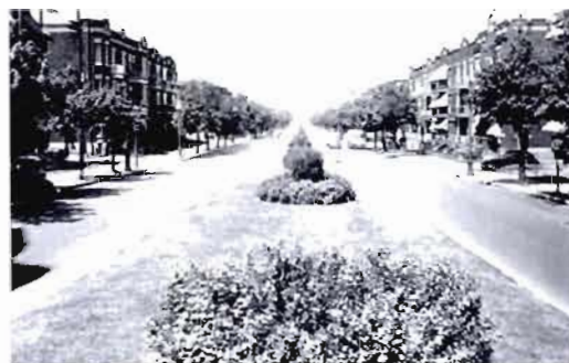
Terre-plein central sur le boulevard Saint-Joseph (coin rue Saint-Hubert) en 1945; Photo : Archive de la ville de Montréal
