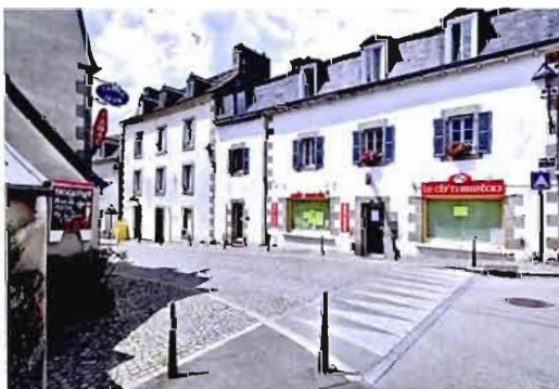
Élévation de la chaussée en France; Photo : Ludo29880, flickr.com, site consulté en avril 2010
