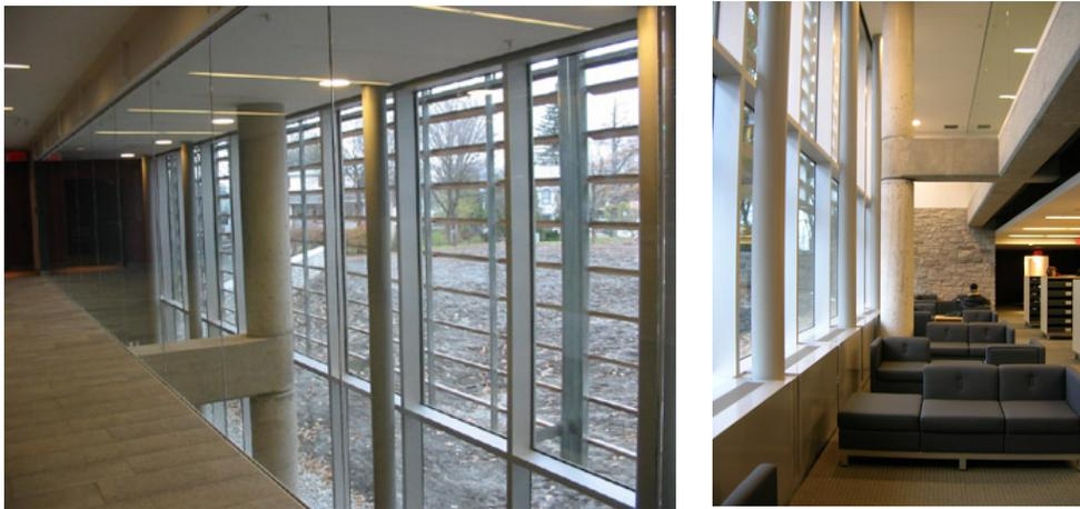
Figure 79. La structure de béton en retrait du mur-rideau.
