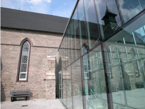
Figure 34. Le mur-rideau de verre et la cloison miroir (Source : Dan S. Hanganu Architectes).
