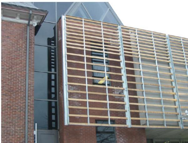
détachement du mur. Le but est de sentir « *le plus possible qu'il [s'agit] d'une peau* » indépendante du mur-rideau et du bâtiment existant (Figure 80).
