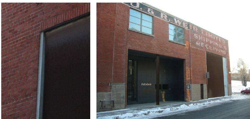
Figure 62. (A) L'idée d'obturation est renforcée par l'ajout d'un joint creux entre le panneau et la brique existante et (B) le contraste avec le percement de l'entrée principale.
