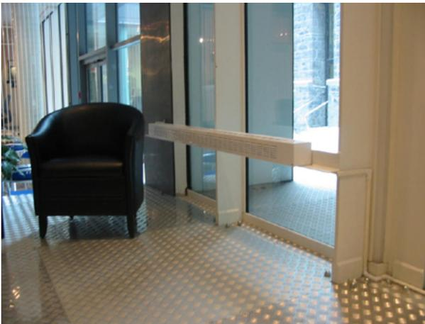
La conception des **plinthes de chauffage** a elle aussi été mise à contribution pour accentuer l'absence de matérialité du mur-rideau. Ces plinthes n'ont pas été placées « à la base, pour vraiment qu'il y ait une continuité du plancher [...] pour sentir que le plancher (et le plafond) filent vers l'extérieur » (Figure 20).
