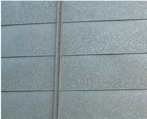
matériaux peu coûteux, dont les **joints horizontaux pliés** se chevauchent et se joignent l'un dans l'autre pour « éviter les infiltrations d'eau ». Les joints verticaux sont cachés par des **moulures** qui créent par la même occasion une certaine « modénature de la façade » (Figure 93). Ces moulures « typiques [de l'] assemblage de gaine de ventilation » ont un prix nécessairement moindre qu'un produit réalisé sur mesure.
