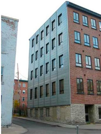
Figure 89. Le revêtement de panneaux d'acier galvanisé du mur latéral.
