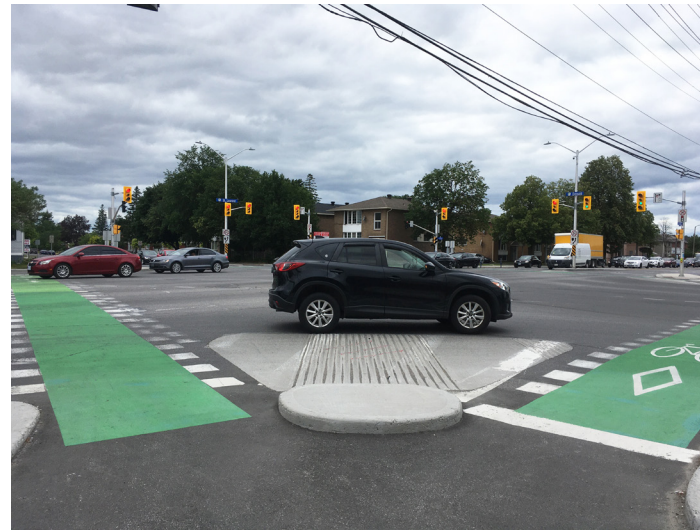
Image 6.10. Tablier rainuré en béton affleurant à l'intersection de la rue Donald et du boulevard St-Laurent
