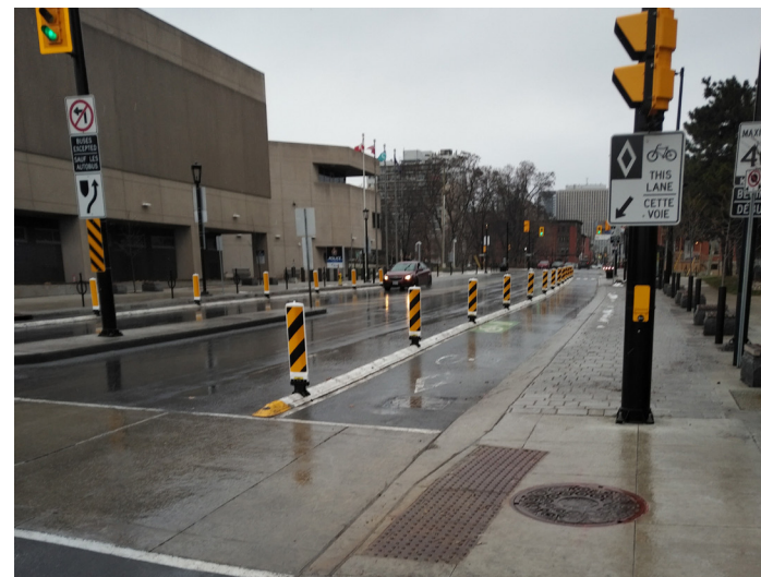
Image 6.9. Mise en œuvre des matériaux de construction rapide sur la rue Elgin
