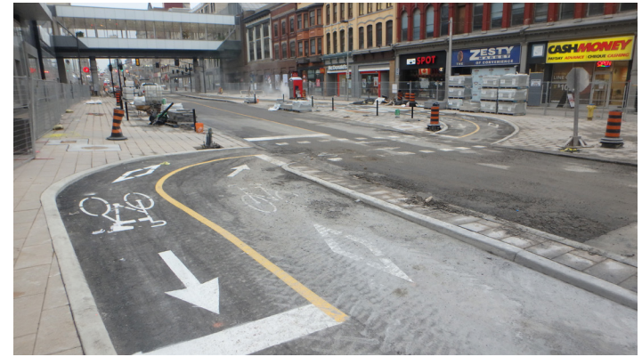
Image 6.1. Bordure de rue de mi-hauteur entre le trottoir et la piste cyclable sur la rue Rideau
