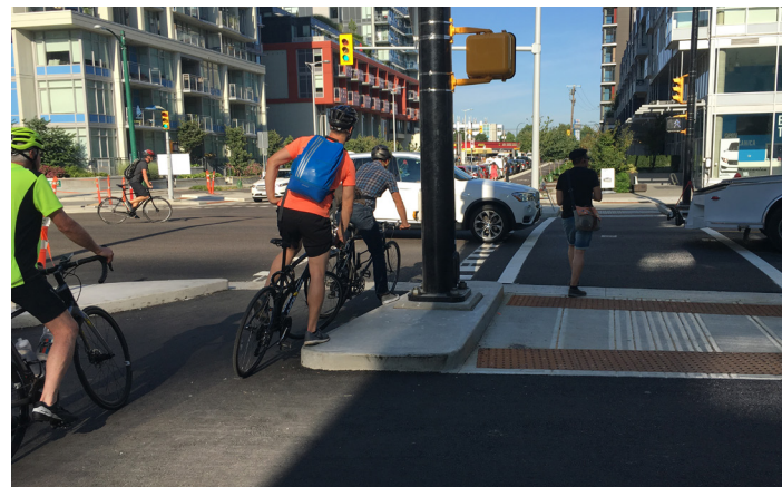
Image 6.8. Intersection protégée à Vancouver; îlot surélevé et infrastructures pour la circulation automobile
