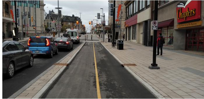
Image 6.4. Puisards de la prise de drainage latérale sur la rue Rideau
