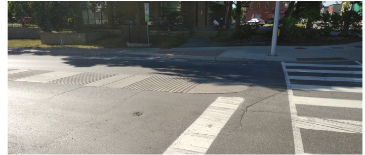
Image 5.4. Exemple de bornage de la ligne médiane en béton nervuré affleurant à l'intersection de l'avenue Gladstone et de la rue Rochester.
