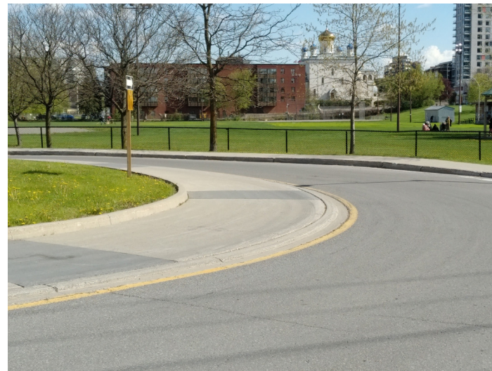
Image 6.11. Tablier surélevé au carrefour giratoire de l'intersection du chemin Bayview Station et de la rue Slidell
