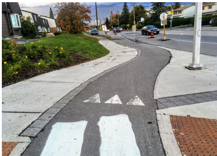
Image 5.8. Exemple de bordure de transition de piste cyclable à l'intersection de l'avenue Fisher et du chemin Dynes
