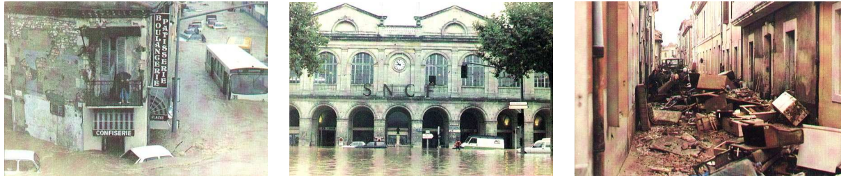
Figure A 6 : Les inondations de Nîmes du 3 octobre 1988 : un sinistre exceptionnel pour une inondation en France, 9 morts, 4 milliards de francs de dégâts ( http://www.prim.net/ ).
