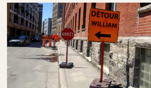
MAUVAISE GESTION DE PASSAGE DE CHANTIER
